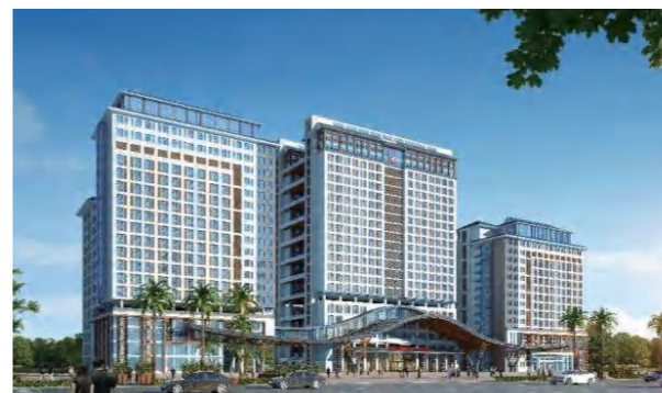
宝安区中医院扩建工程 (二期)
