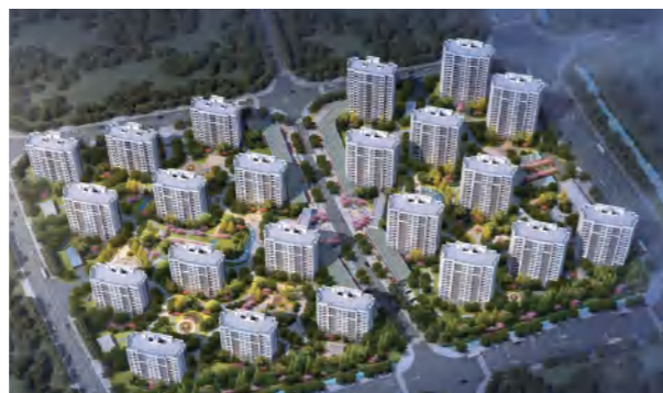
天台县始丰街道唐兴大道玉湖区块改造一二期工程
