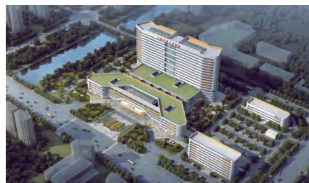
凤台县人民医院新院区及二期建设工程
