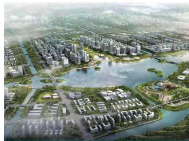
台州东部新区市政道路基础设施建设
