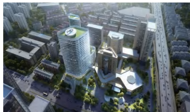
浙江大学医学院附属邵逸夫医院五期工程
