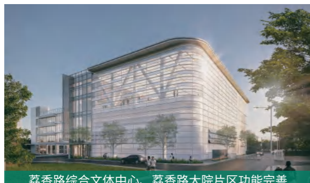
荔香路综合文体中心、荔香路大院片区功能完善 及建筑安全隐患整治工程
